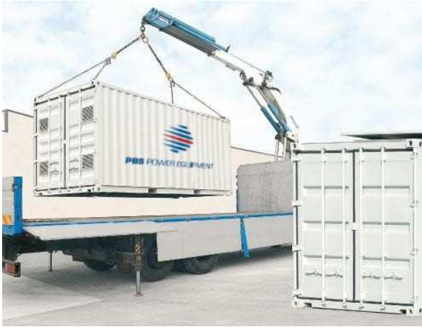
Obr. 4 Přeprava kotelny
